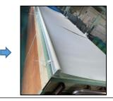
③2階南面の開口部からエアコンの冷気が一階に逃げないよう、レールカーテンを取り付けました。開閉も簡単で、涼しく作業できるようになりました。by武知伸一・野上大介・中川誠
